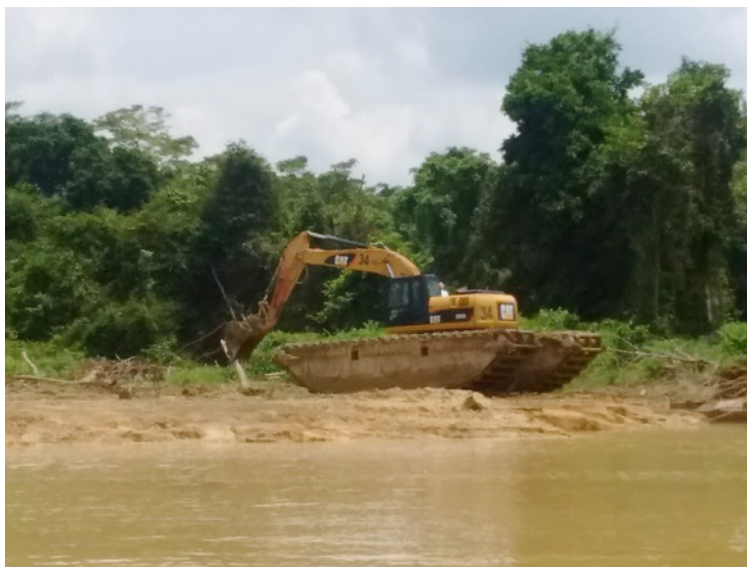
Figura 1.6. Retroexcavadora retirando una fracción del horizonte.
